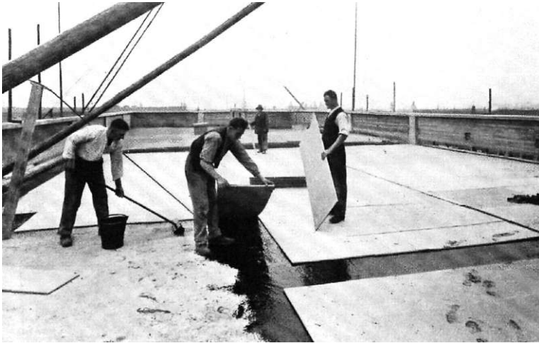
Bauarbeiter beim Verlegen der Platten des begehbaren Dachgeschosses
