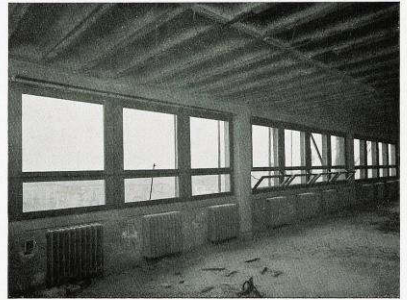
30 Der Rohbau ohne Zwischenwände - The rough work, without partitions - Le gros oeuvre, sans cloisons
